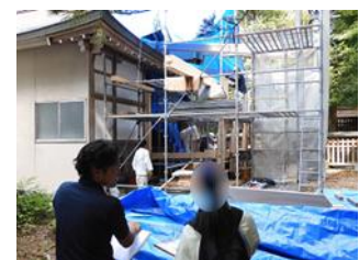
写真3：儀式殿増築工事
