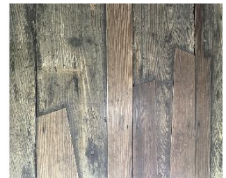
写真5：修復した床の様子
