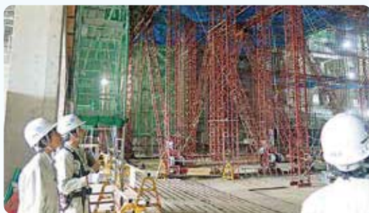
アリーナ建設現場を見学しました。
