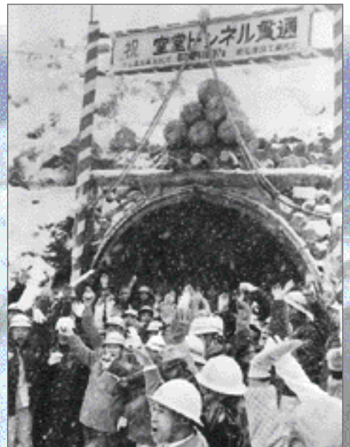
室堂トンネル（立山トンネル） の貫通（1967年10月27日）。
