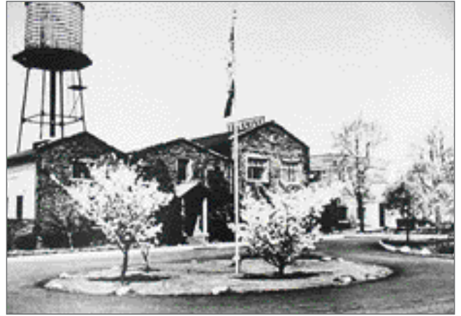
アメリカ(アリゾナ州)・ピオリアに建てられた高峰工場。
