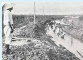
岸渡川 ほりさく 水中堀鑿作業 (昭和19年8月頃)
