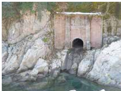
今も残る旧庵谷発電所の遺構 (神通川寺津橋西詰め)
